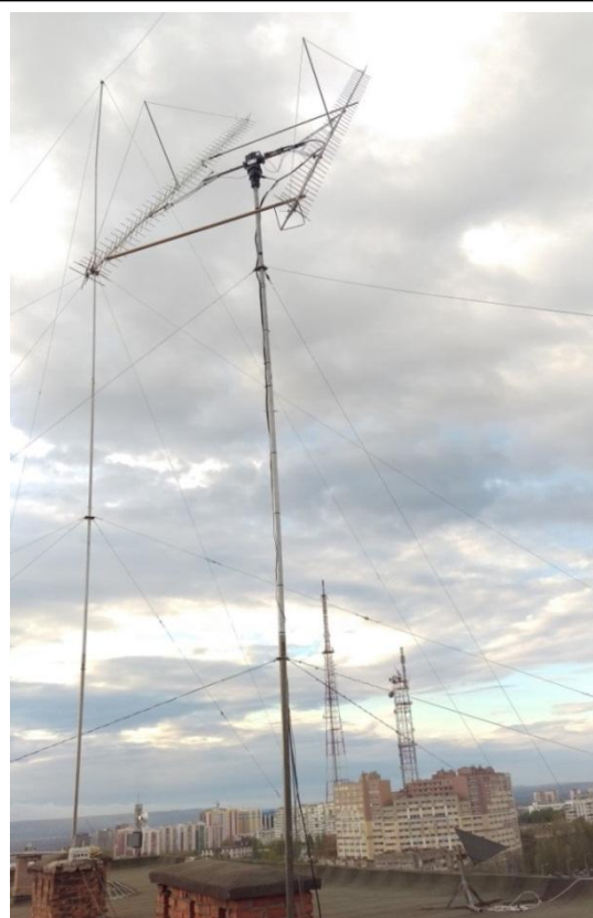
Рис. 2. Внешний вид наземной антенны отражённого канала БиРЛК МКА «АИСТ-2Д», установленной на здании ПГУТИ
