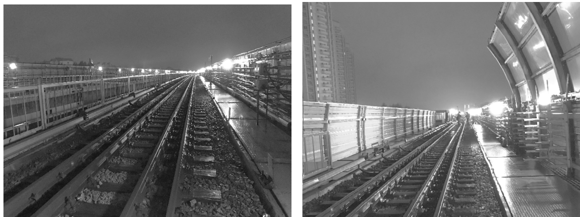
Рис. 8. Открытые участки на эстакадах с разным типов ограждений и количеством путей на участке
