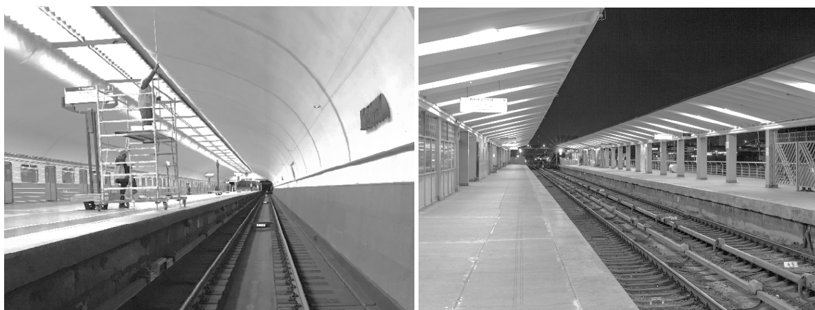
Рис. 10. Подземная и открытая наземная станции
