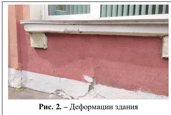
Рис. 2. – Деформации здания
